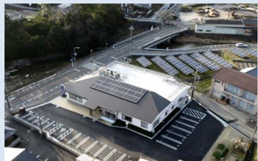
運用中の太陽光発電システム
