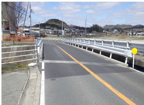
令和2年度補修完了（紫合橋）
