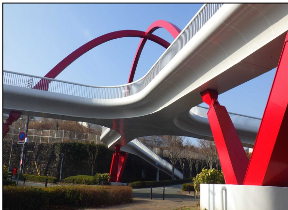
令和2年度補修完了（きらきら橋）
