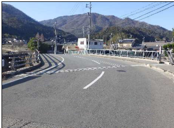
令和5年度補修完了（出合橋）
