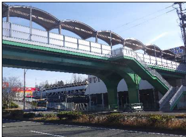
令和7年度補修完了（日生中央駅前連絡橋）
