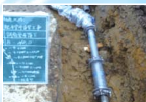
●老朽管路の更新工事 耐震化工事 (GX形ダクタイル鋳鉄管 更新状況: 柏原地内)
