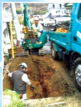
●配水管漏水修理 (修理状況: 荘苑地内)
