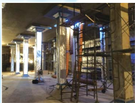
●施設の整備 耐震化工事 (伏見台低区配水池 内部の補強工事状況)
