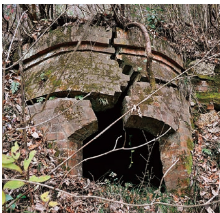
▲堀家製錬所跡 煙道連結部
