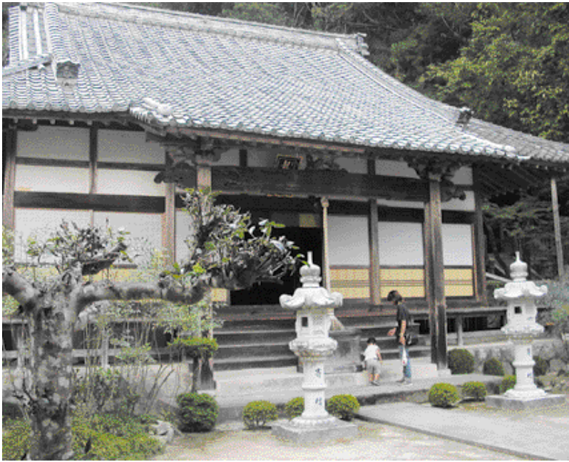
▲木津にある天澤寺は、楊津院の跡と伝えられています
