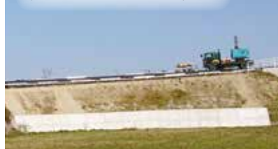
高速道路工事の様子
