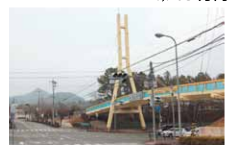
橋りょうの計画的な維持補修のため、長寿命化計画を策定するとともに、パークタウン内のトンガリ橋修繕工事を実施
