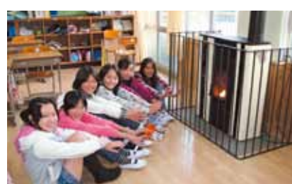
木質バイオマスを燃料としたペレットストーブを本庁舎1階ロビーと大島小学校に設置し、木質資源の活用について啓発
