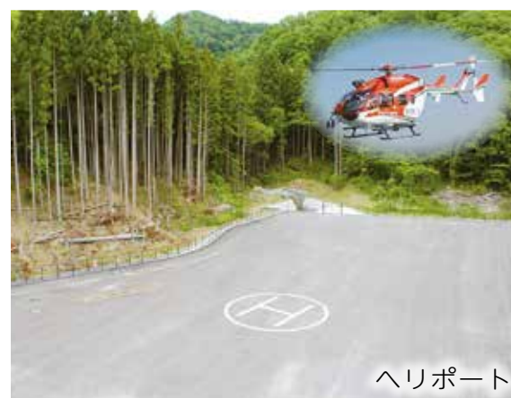
建設工事の様子
