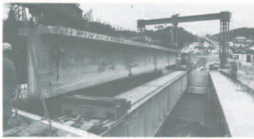
橋々と整備が進む都市計画道路川西猪名川線（写真は新設の広橋橋）
