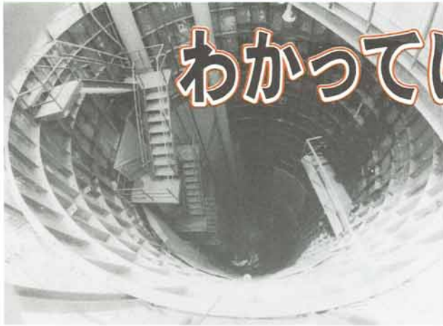
着々と進む下水道中央幹線工事（北田原地内）
