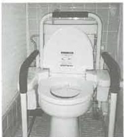
便器の両サイドに手すり が付きました
