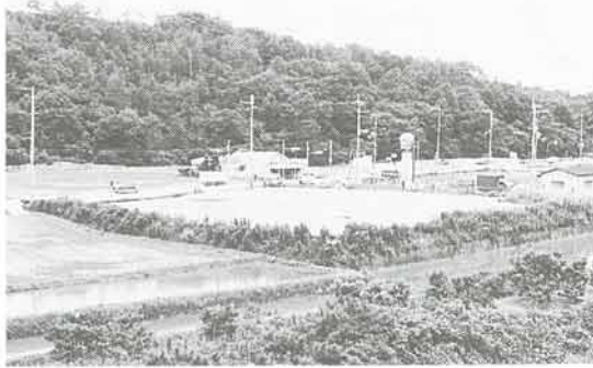
▲農村と都市との交流の拠点を目指す休憩施設などの建設予定地(万善地内)
