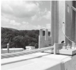
▲支柱に差し込むパネルは頑丈なワイヤーやバネで何重にも固定。事故での落下を防ぎます。
