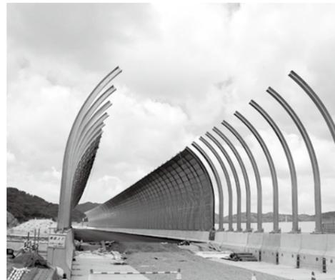
道路沿いに支柱を等間隔に立て、その間にパネル(遮音板)を挟み込み固定させます。
