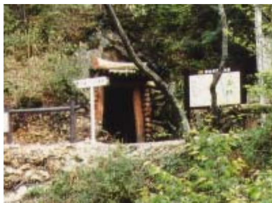
安全整備を施した青木間歩
