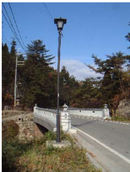
景観に配慮して整備した銀山橋
