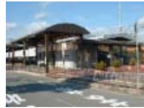
自転車駐車場(日生中央駅前)
