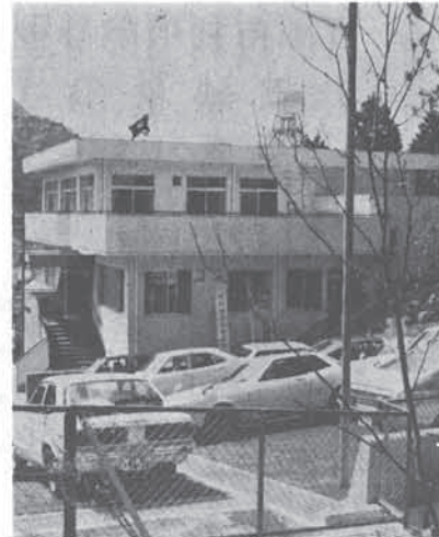
差別のない明るい町づくりの拠点にと建設された木津総合会館
